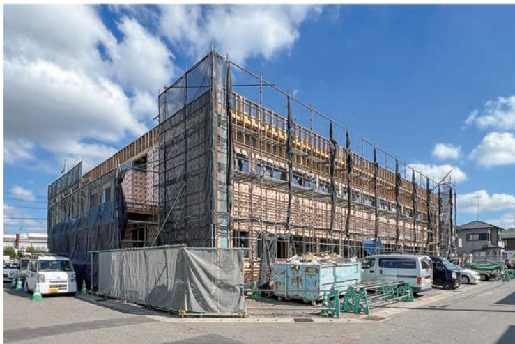
**上** 棟・金物検査が問題なく無事に完了し、屋根葺き、外壁下地組み、内装下地張りりと、着々と工事が進んでおります。この建物は外断熱なので躯体と外壁材の間にフェノールフォームという板状の断熱材を設置しています。内部も入居者の個室の間仕切壁や天井面にグラスウール断熱材を充填しているので、老人ホームとしての住環境・温熱環境は向上しているのではないかなと思っています。(設計・安藤)
